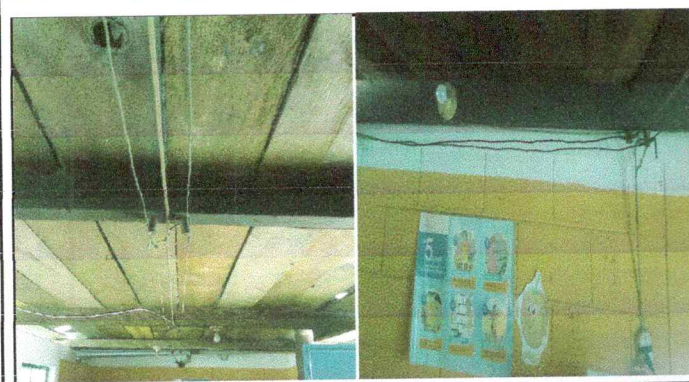
Foto 13 y 14: Cableado electrico de la cocina y Focos.
