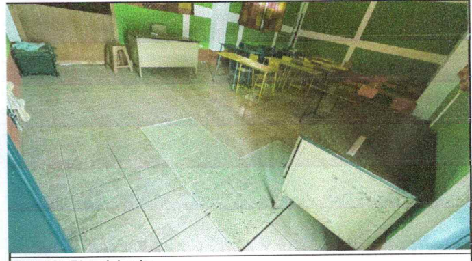
Foto 12: Piso del aula.
