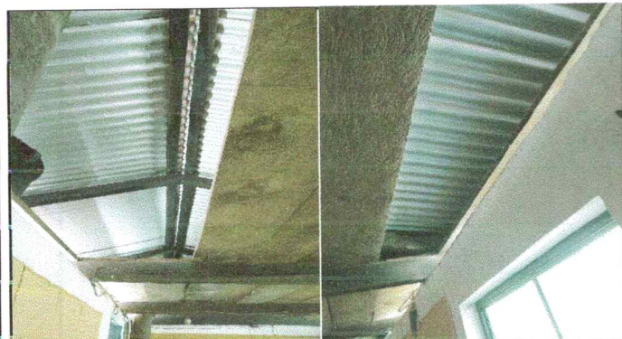
Foto 3 y 4: Estructura de soporte de madera de la lámina de cocina.
