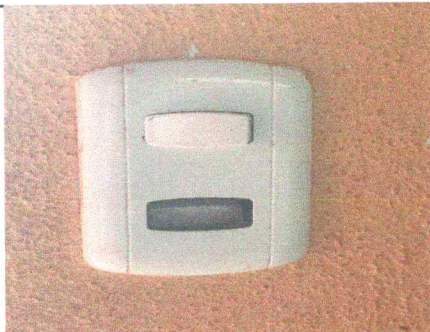
Foto 9: Sustrucción de interruptores
