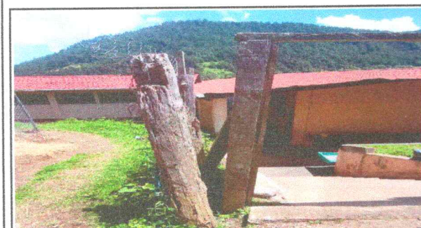
Foto 5: Sustitución de columnas de madera por columnas de concreto
