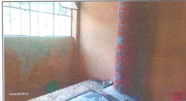
Foto1: Mejoramiento Cocina paredes (azulejo)
