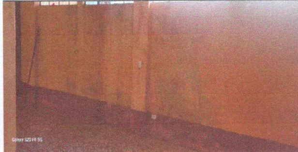
Foto 10: Aplicación de pintura interior del salón escolar
