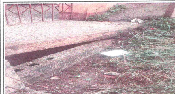
Foto 3: Mejoramiento malla en Muro Perimetral
