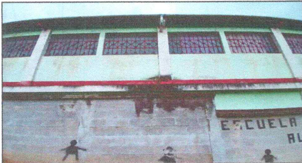
Foto 7: PINTURAS EN AULAS Y MUROS EXTERIORES E INTERIORES
