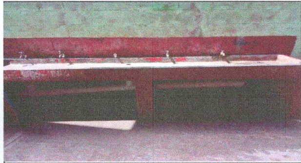
Foto 4: MEJORAMIENTO DE AZULEJOS EN LAVAMANOS
