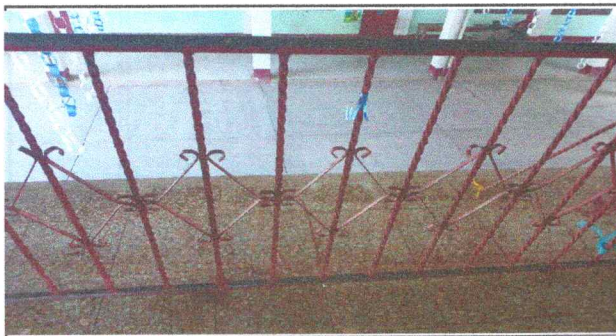
Foto 9: MANTENIMIENTO DE BARANDAS EN EL SEGUNDO NIVEL
