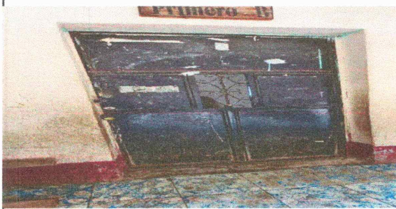
Foto 3: Sustitución de puertas de metal por puertas de metal
