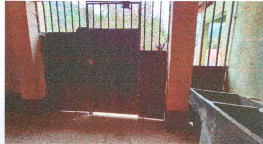
Foto 2: Sustitución de un portón
