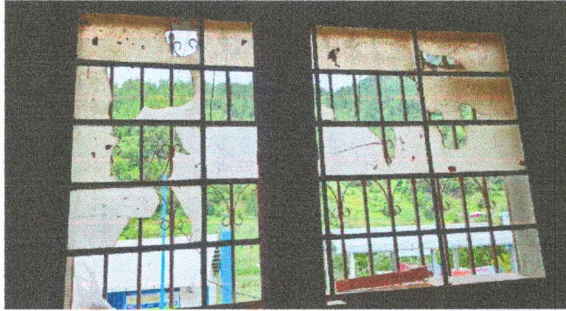
Foto1: Sustitución de ventanas
