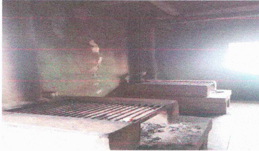
Foto7: Pintura de muros interiores de la cocina
