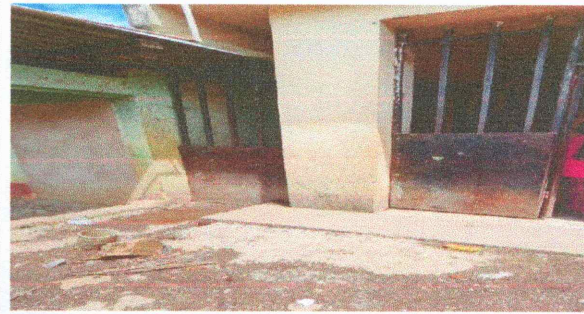
Foto 8 Mejoramiento del portón 2
