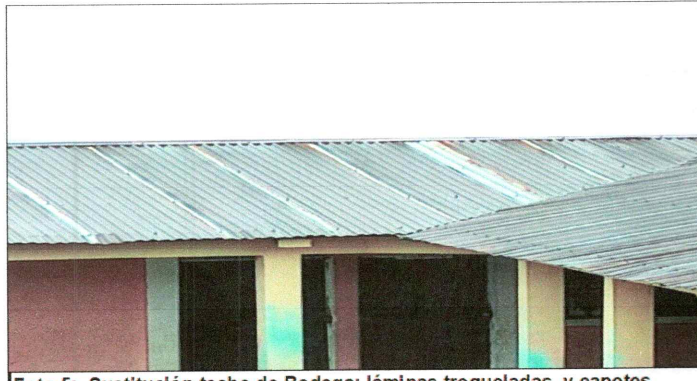
Foto 5: Sustitución techo de Bodega: láminas troqueladas y capotes calibre 26
