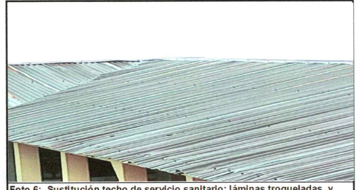
Foto 6: Sustitución techo de servicio sanitario: láminas troqueladas y capotes calibre 26
