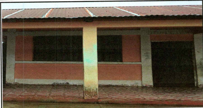
Foto 7: Sustitución techo de aula dos: láminas troqueladas y capotes calibre 26
