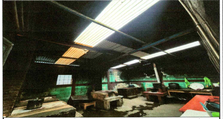
Foto2: Lijado y aplicación de pintura anticorrosiva color negro en vigas de metal.
