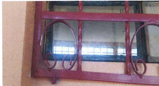
Foto 16: sustitución de vidrios de ventanas 32cm x 19cm
