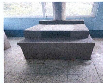
Foto 12: sustitución de planchas de metal de tres hornillas
