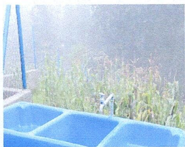
Foto 11: sustitución de de llaves de chorros
