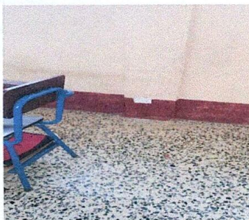
Foto 3: sustitución de tomacorriente
