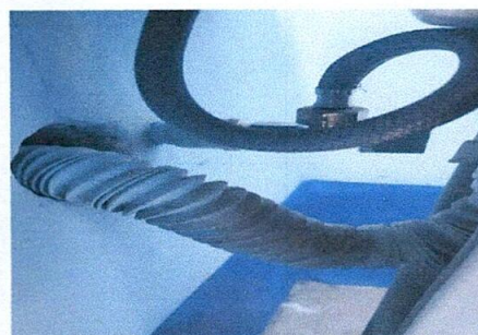
Foto 6: sustitución de mangueras de agua para lavamanos
