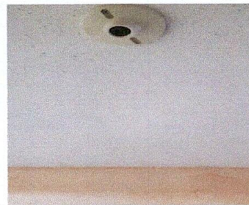
Foto 2: sustitución de plafoneras
