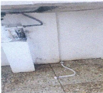
foto 9: mangueras para lavatrastos
