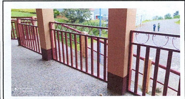
Foto 19: sustitución de barandas de metal (260 X100)(366 X100)(366 X 100)(214 X 100)(208 X 100)(115 X 100)(142 X 100)(366 X 100)(258 X 100)
