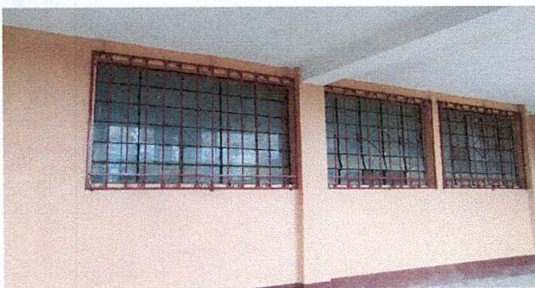
foto 17: sustitución de balcones de metal color rojo óxido 1.76 m x 1.31 m, 2.02 m x 1.31 m, 1.01 m x 1.31 m, 1.75 m x 1.31 m, 1.98 m x 1.31 m, 1.80 m x 1.35 m, 2.02 m x 1.35 m, 1.79 m x 1.35 m, 2.06 m x 1.35 m
