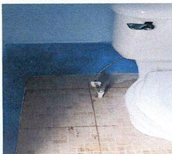
Foto 5: sustitución de mangueras de agua para inodoro
