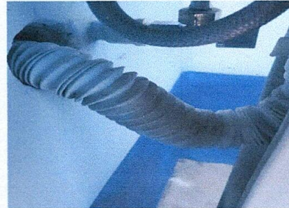
Foto 8: sustitución de llaves de paso para lavamanos
