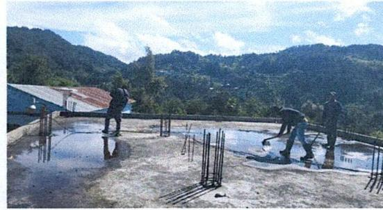
Foto 20: impermeabilización de losa (21 x 9 metros 2)
