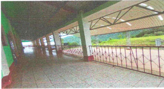
Foto 13 Mantenimiento a barandas (lijado y aplicación de pintura)
