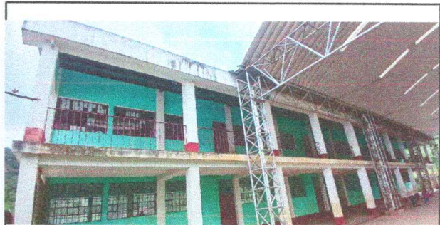
Foto 10: pintura en muros exteriores e interiores
