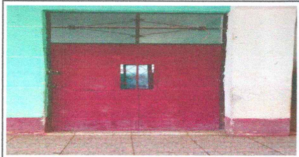
Foto 9: Sustitución de chapas y mantenimiento de puertas
