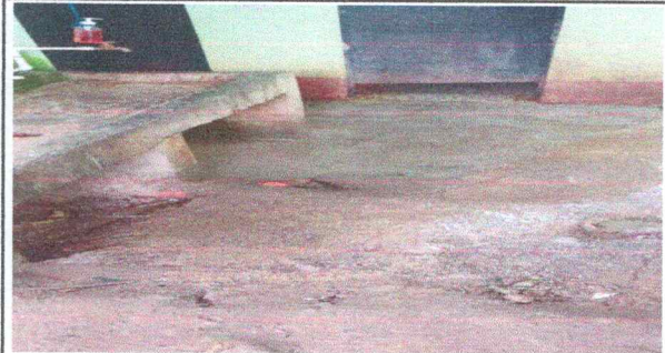
Foto 8: Mejoramiento de corredor para baños con losa de cemento
