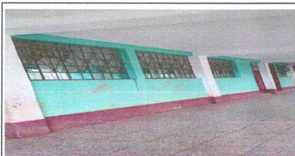
Foto 11: colocación de balcones a ventanas
