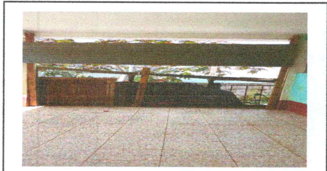
Foto 3: Mejoramiento de altura y ancho de una estructura metálica de baranda
