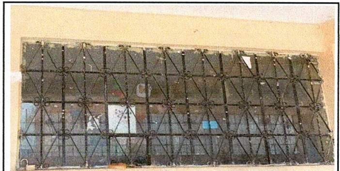
Foto 6: ventanas paara colocar balcones
