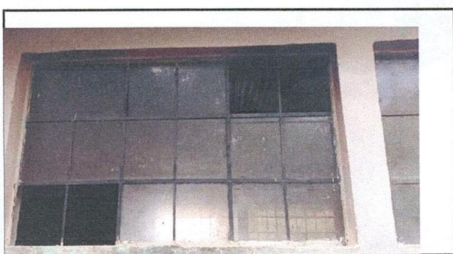
Foto 4. ventanas en malas condiciones
