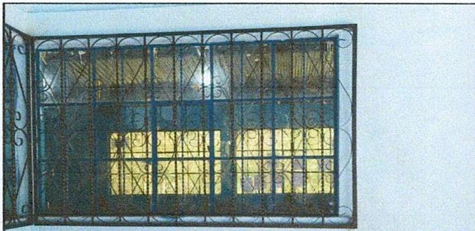
Foto 15: Mantenimiento a estructura de metal de ventana de 2.14mx1.18m.
