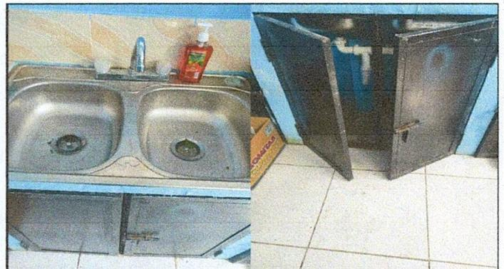
Foto 16: Sustitución de lavatrastos (incluye accesorios como llave de paso, uniones y tubos pvc y otros)
