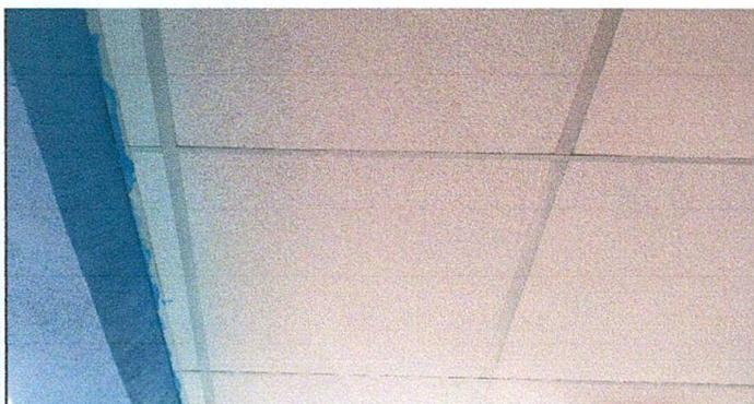
Foto 11: Sustitución de lámina, por lámina troquelada aluzinc calibre 26 1.15 m2
