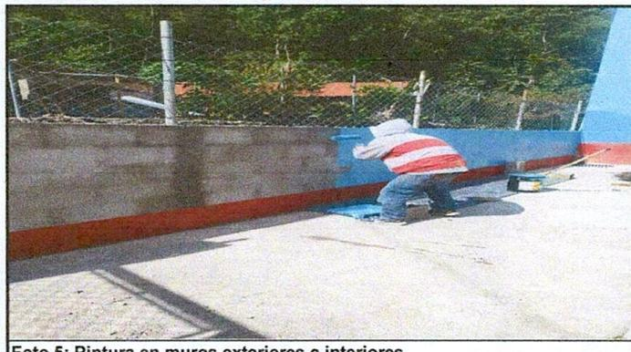
Foto 5: Pintura en muros exteriores e interiores
