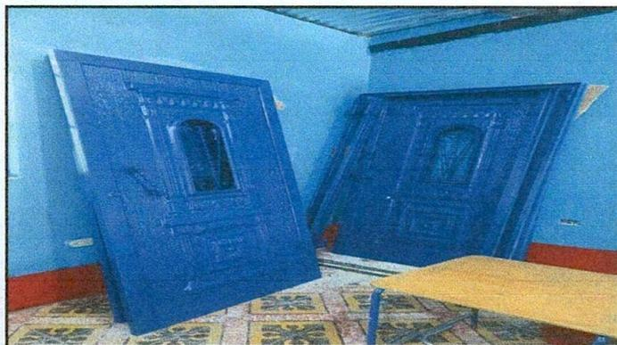
Foto 3: Sustitución de puertas de 1m x 2.9m
