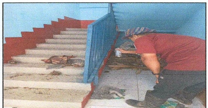
Foto 12: Mantenimiento a barandas de metal
