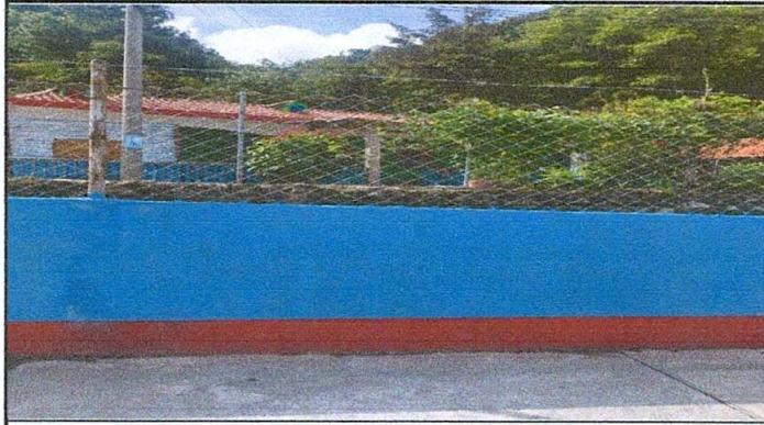
Foto 1: Reparación de muro perimetral de block con tubo hg y malla galvanizada, soleras intermedias y columnas. De 42 ml
