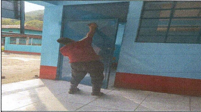
Foto 13: Mantenimiento a estructura (lijado, cambio de tubo , cepillado, sujeciones, aplicación de pintura) de 95cm x2.55m
