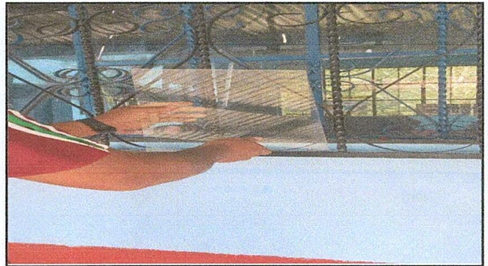
Foto 8: Sustitución de vidrios de 35cmx39cm.
