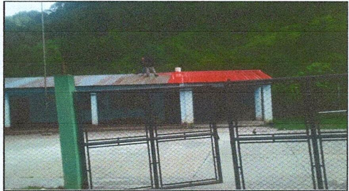
Foto 14: Mantenimiento a estructura de soporte de metal
