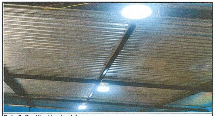
Foto 6: Sustitución de plafoneras
