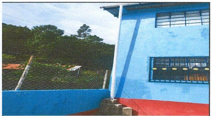
Foto 4: Reparación de bajada de agua pluvial, tubo PVC 3"
