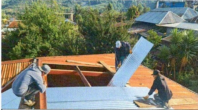
1. SUSTITUCION DE LAMINA, POR LAMINA ACANALADA CALIBRE 26
