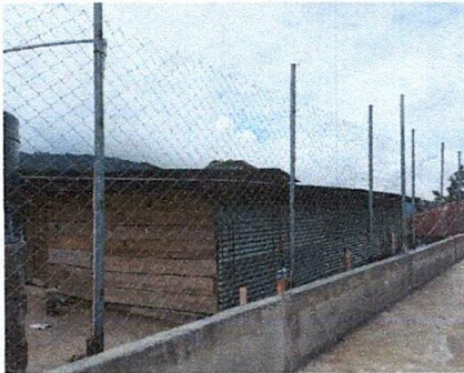
FOTO 9: Sustitución de malla galvanizada en cerco de dos filas y tubo galvanizado.
