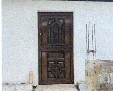
FOTO 7: Sustitución de puerta de madera por puerta de metal, con chapa y marcos de metal, en módulo de cocina.
