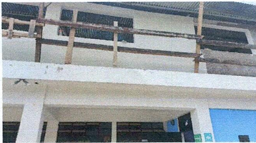
FOTO 5: Aplicación de repello y cernido de paredes en interior y exterior. Módulo de cocina.
