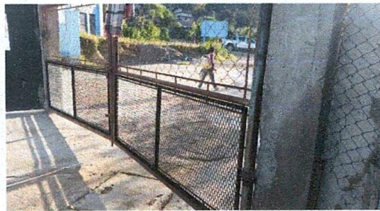
FOTO 4: Mantenimiento de portón de metal (lijado, cepillado y aplicación de pintura)
