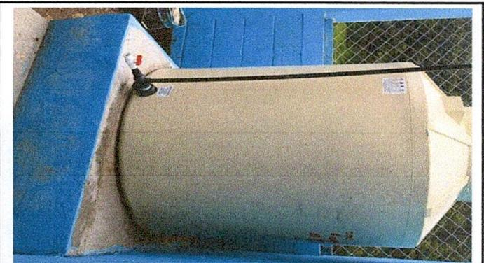
Foto 10: Sustitución de depósito de agua
