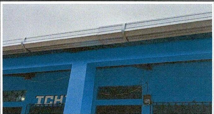
Foto 4: Sustitución de canal
