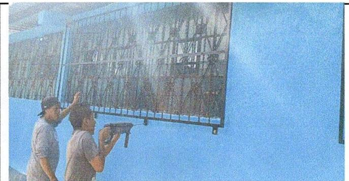
Foto 16: Fabricación e instalación de balcones
