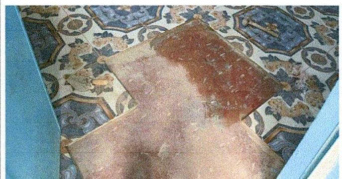
Foto 14: Sustitución de piso por cerámico
