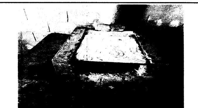
Foto 11: Sustitución de plancha
