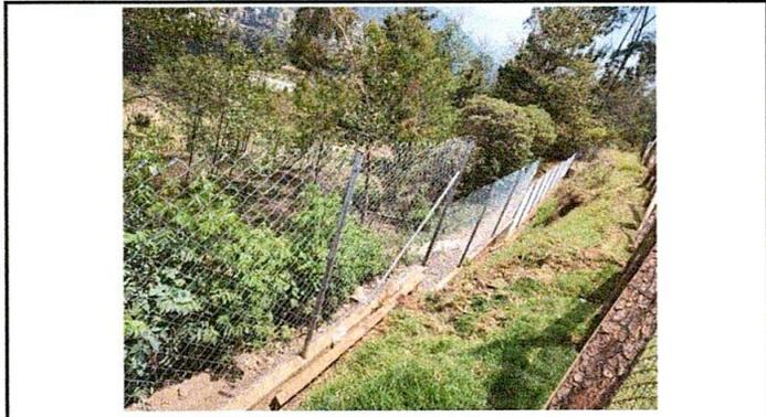
Foto 3: sustitución de malla galvanizada en perímetro de circulación.
