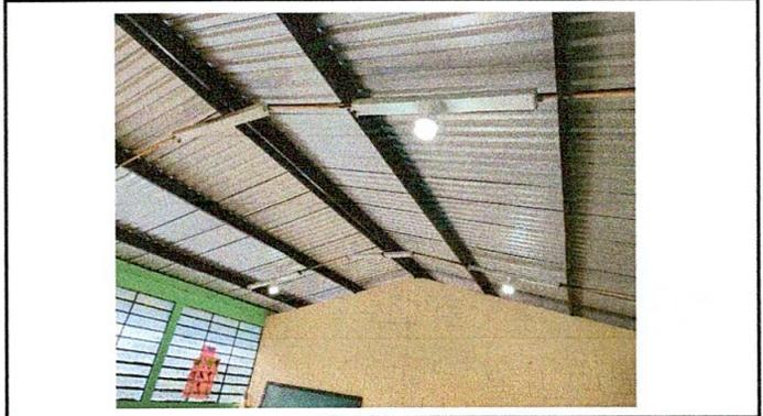
Foto 4: sustitución de ducto eléctrico y accesorios.
