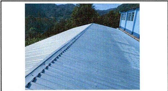
Foto 1: sustitución de láminas por láminas troqueles aluzinc.
