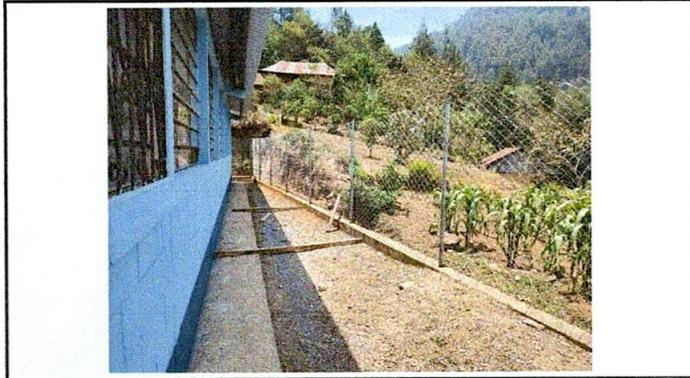
Foto 3: instalación de malla galvanizada en perímetros de circulación
