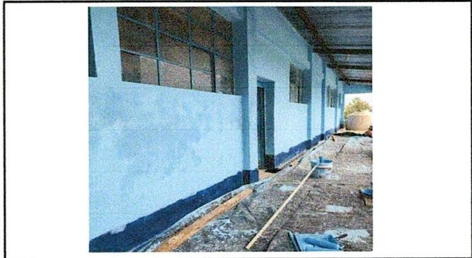
Foto 2: proceso de pintura de muros exteriores
