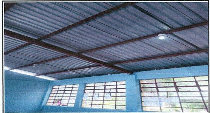
Foto 4: Sustitución de focos y plafoneras
