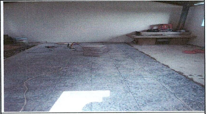
Foto 2: Sustitución de piso a piso de granito
