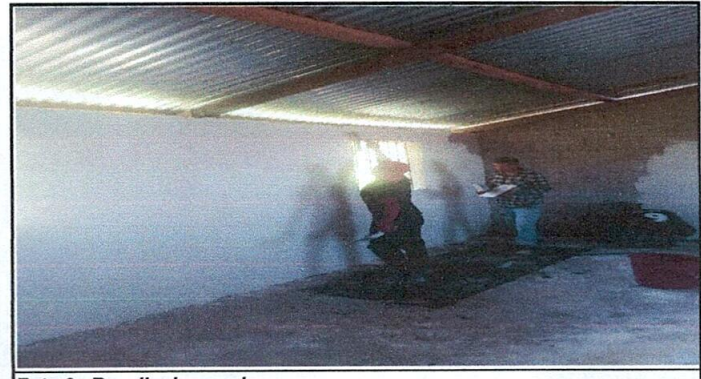
Foto 6: Repello de paredes
