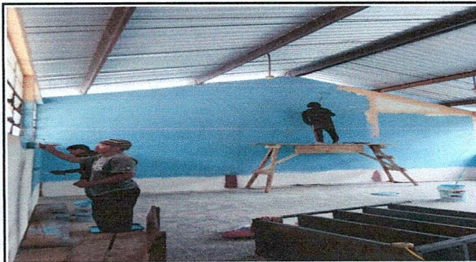
Foto 3: Pintura en paredes exteriores e interiores
