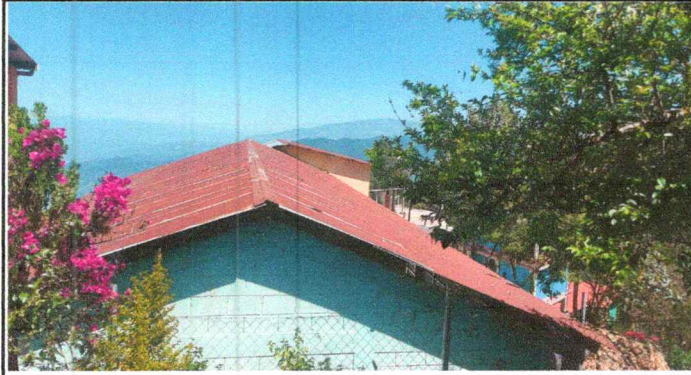
Foto 1: Sustitución de láminas
