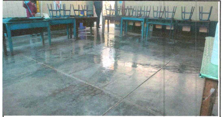
Foto 2: Sustitución de piso a piso de granito
