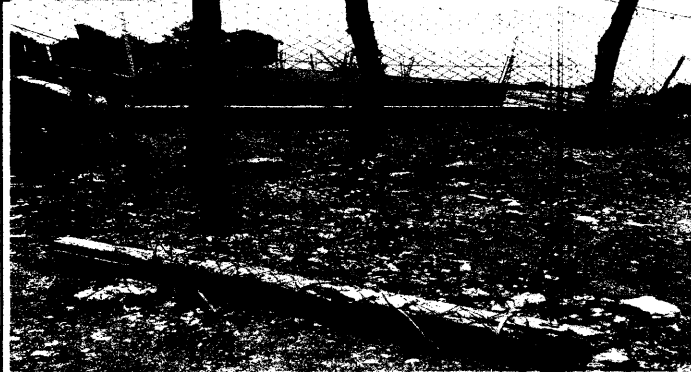
Foto 2: la malla se encuentra en mal estado por lo que prioriza su sustitución.
