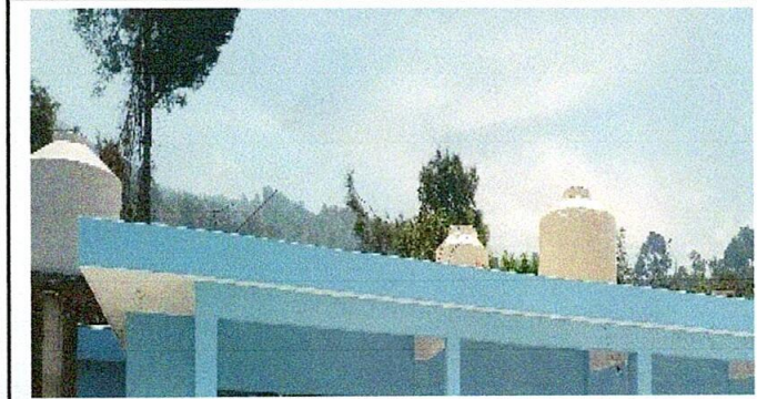
Foto1: Asi se finalizo el modulo 18 REPARACION Y MANTENIMIENTO DE CISTERNAS/DEPOSITO DE AGUA
