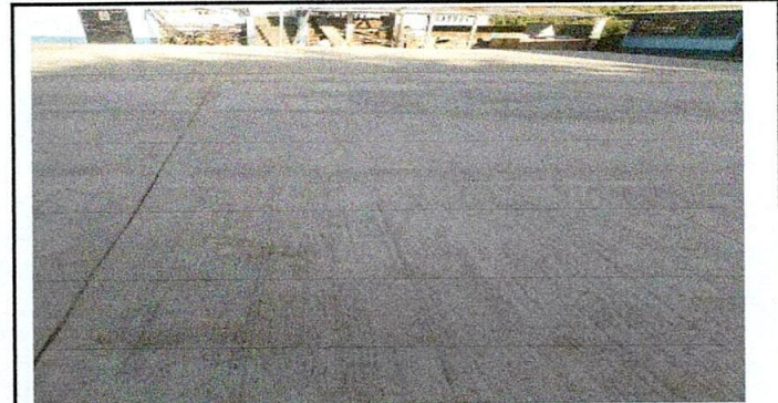
Foto 6: Asi se finalizo el modulo 16 LOZA DE PATIO
