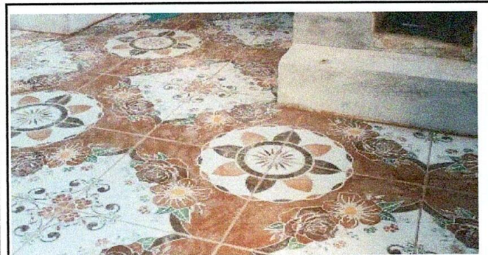
Foto 3: Asi se finalizo el modulo 6 de reparacion de piso ceramico
