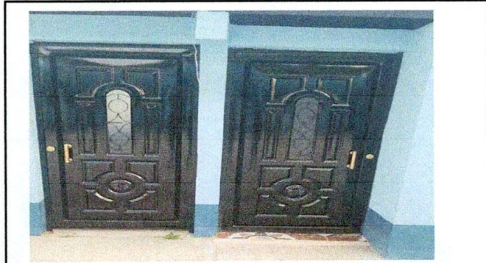
Foto1: Asi se finalizo el modulo 4 PUERTAS DE METAL, sustitucion de dos puertas de metal
