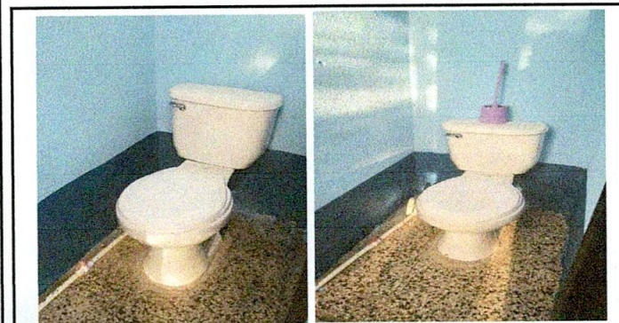
Foto 5: Asi se finalizo el modulo 10 SERVICIO SANITARIO Y SUS ACCESORIO
