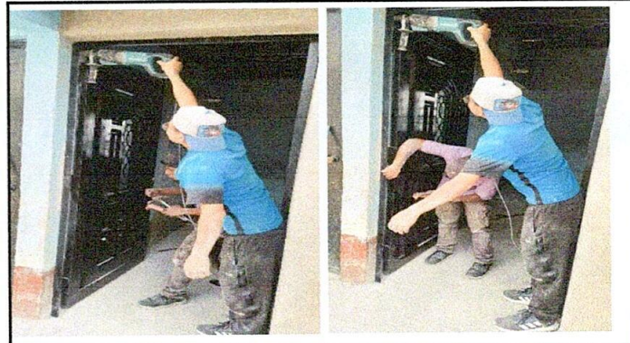
Foto 4: Proceso de la susticion de puertas
