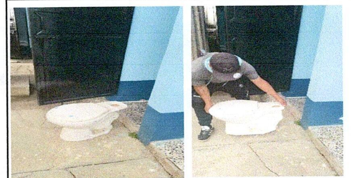
Foto 6: proceso de sustitucion de inodoro
