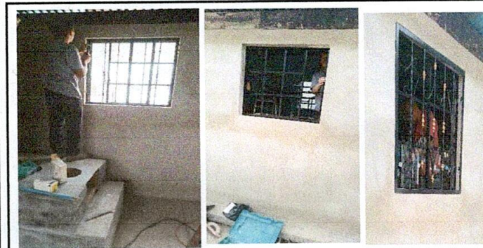
Foto 5: proceso de sustitucion de ventanas y balcon
