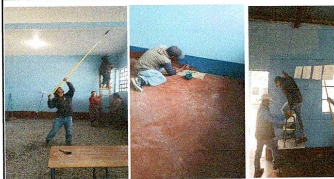
Foto 3: Proceso de pintado del edificio escolar exterior einterior
