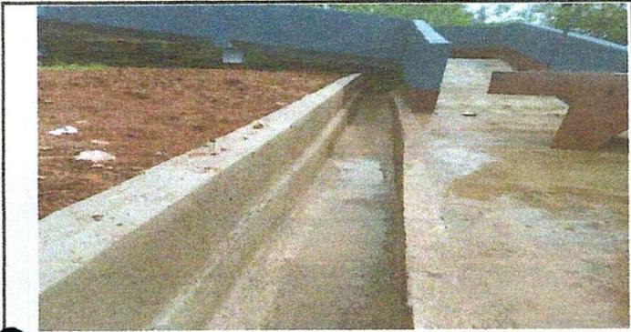
Foto 1: Reparación de cuneta de concreto
