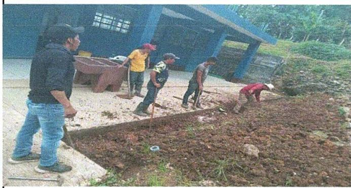
Foto1: Reparación de cuneta de concreto
