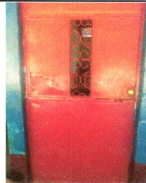
Foto 4: Sustitución de puertas
