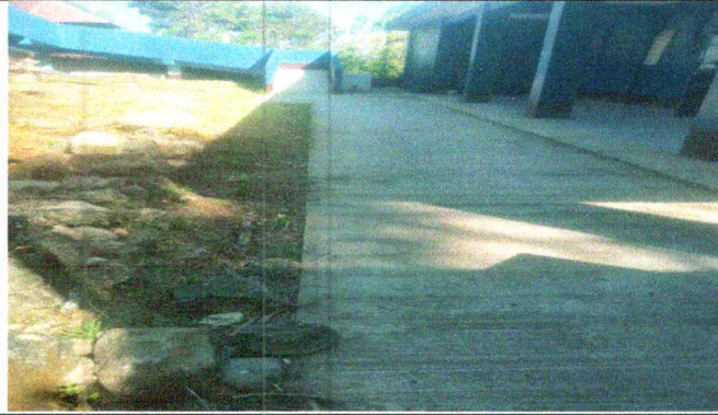
Foto 1: Reparación de cuneta de concreto
