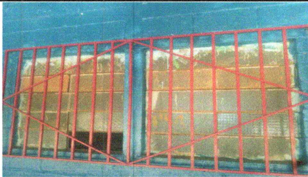
Foto 3: sustitución de estructura de metal de ventana
