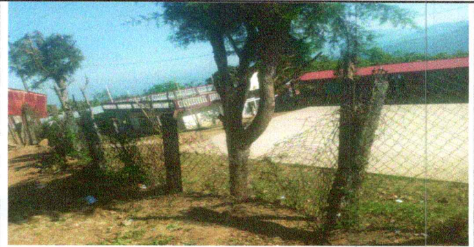
Foto 2: Reparación de muro perimetral
