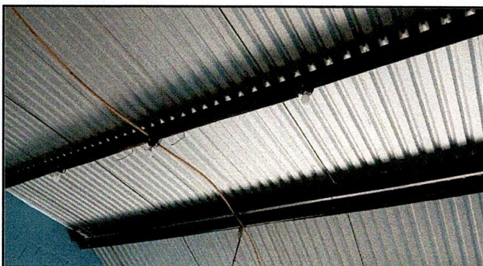
Foto 3: Aplicación de pintura en estructura de techo
