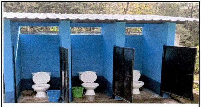
Foto 6: Sustitución de lámina y aplicación de pintura
