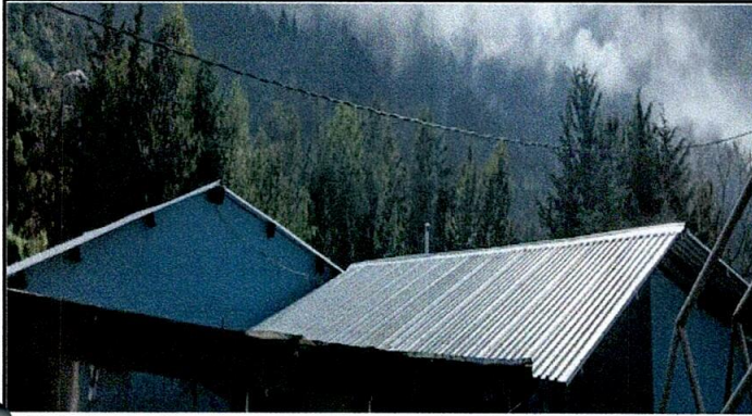
Foto1: Sustitucion de lamina por lamina toquelada
