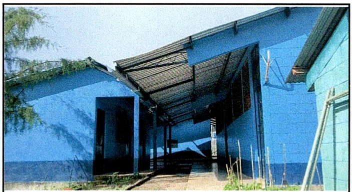
Foto 4: Aplicación de pintura
