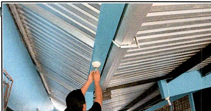
Foto 11: Instalación de focos ahorradores
