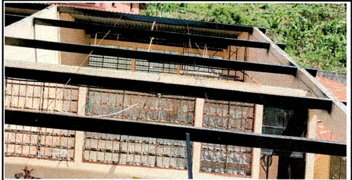
Foto 2: Mantenimiento a estructura de techo
