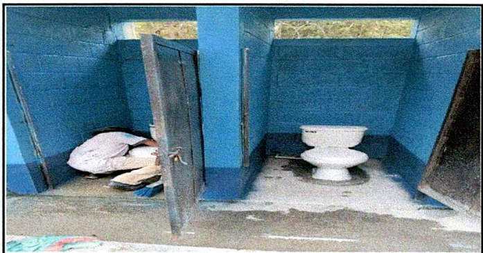
Foto 6: sustitución de inodoro
