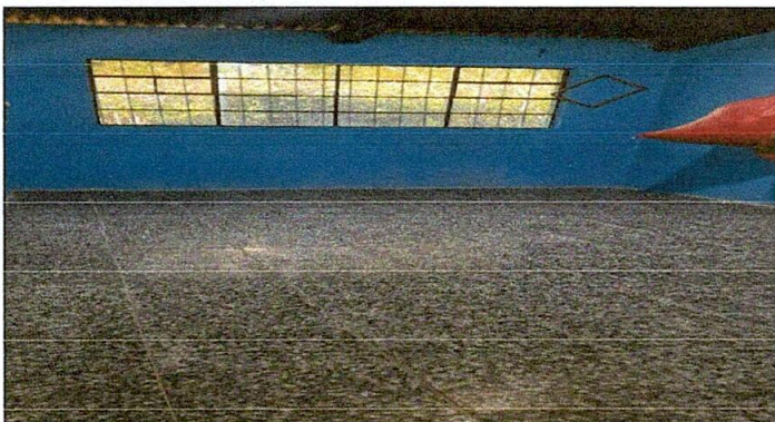
Foto 3. Instalación completa de piso de granito en la bodega y dirección del centro educativo
