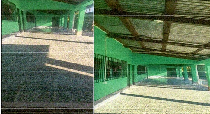
Foto 1. Se puede observar la instalación completa del piso de granito en el corredor del aula 1 y 2 del centro educativo
