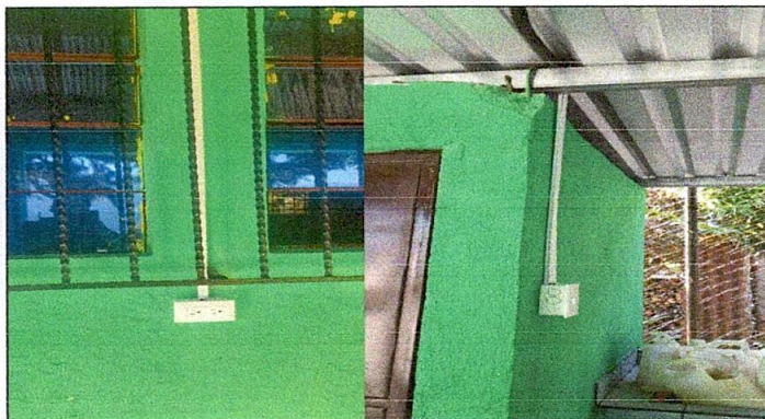
Foto 9. Se puede observar la instalación completa de toma corrientes y apagadores sobrepuestos en el centro educativo
