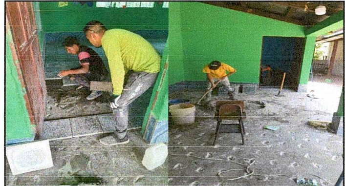
Foto 2. Se puede observar el proceso de ejecución de la sustitucion de piso de concreto a piso de granito en el area de Aula 1 y 2. De la misma manera en el area del corredor
