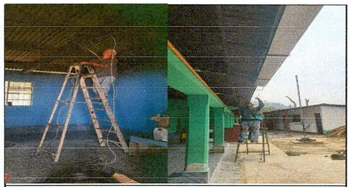
Foto 6. Se puede observar la ejecución en los trabajos de sustitucion de instalaciones electricas y sustitución de canaletas de metal para baja de agua en el centro educativo
