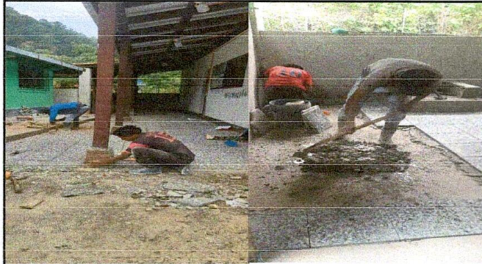
Foto 1. Se puede observar el proceso de ejecución de la sustitucion de piso de concreto a piso de granito en area de cocina y corredor de aula 3 y 4. de igual manera se puede observar el remozamiento de sócalo y pilares
