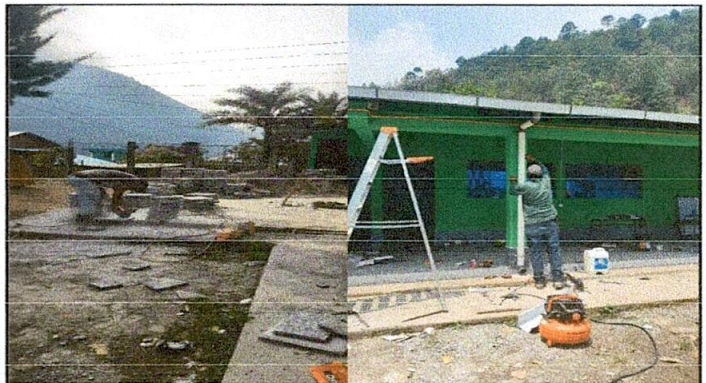
Foto 10. Se puede observar Los diferentes encargados de trabajo ejecutando los diferentes modulos remozados en el centro educativo.
