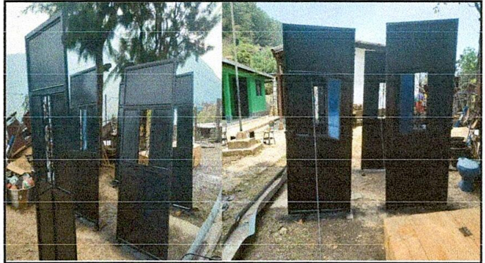
Foto 8. Se puede observar las puertas con nueva pintura con su debido mantenimiento
