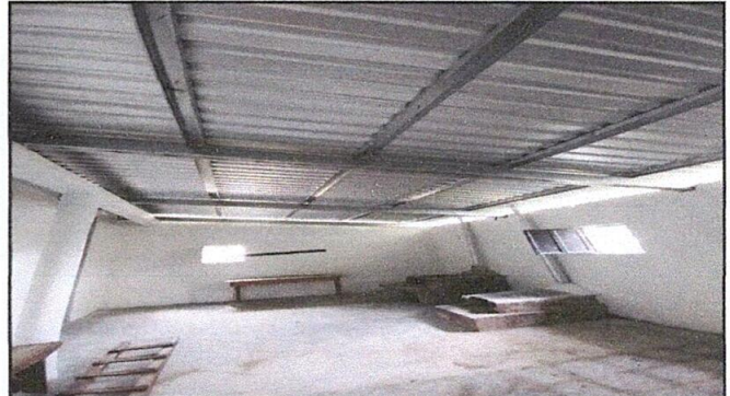
Foto 2: Sustitución estructura de madera por costanera galvanizada
