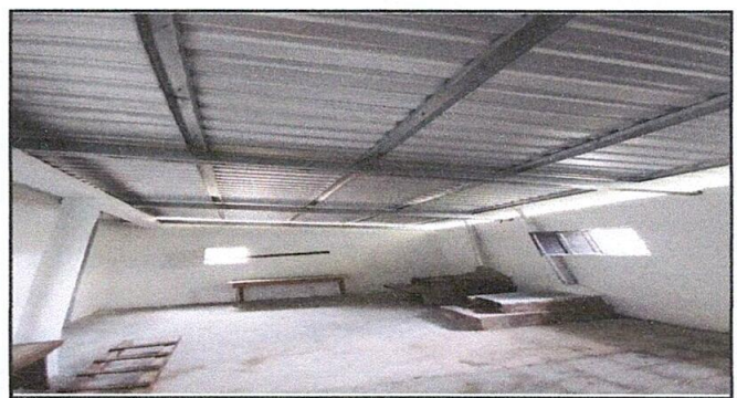
Foto 6: Sustitución de piso de concreto por piso de granito.
