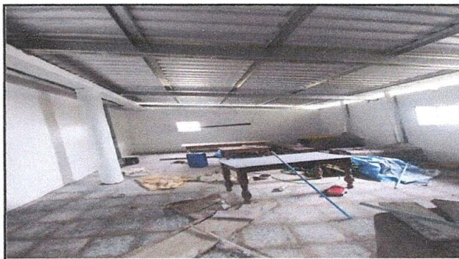
Foto 10: Pintura en muros exteriores e interiores.
