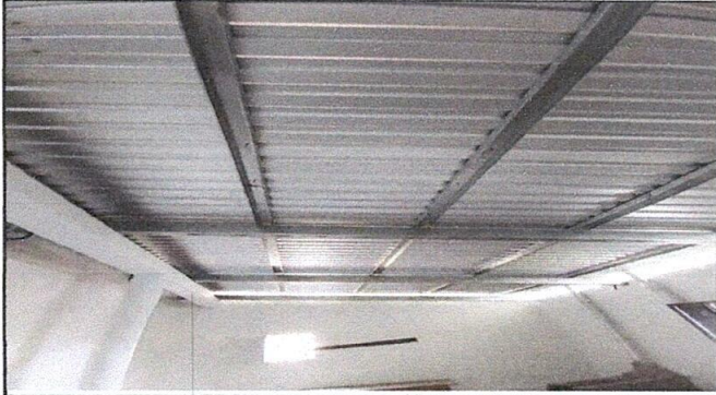
Foto 1: Sustitución de lámina, por lámina troquelada Ternium Zintroaluminum calibre 26.
