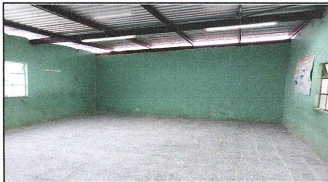
Foto 7: Sustitución de piso de concreto por piso de granito.
