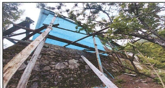
Foto 11: Pintura en muros exteriores e interiores.
