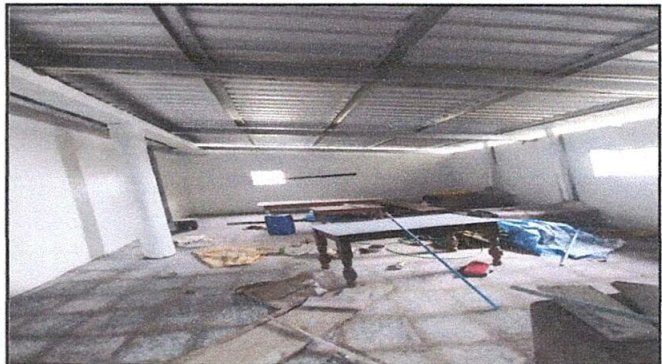
Foto 10: Pintura en muros exteriores e interiores.
