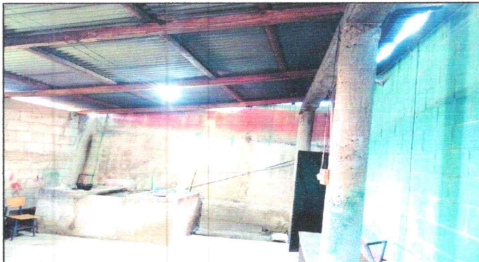
Foto 3: Sustitución de estructura de madera por costanera de 4*2.
