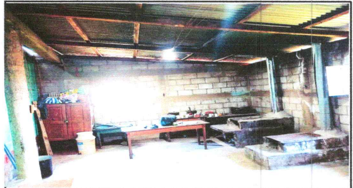
Foto 2: Sustitución de estructura de madera por costanera de 6*2.
