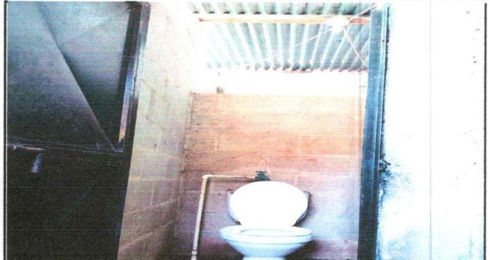
Foto 2: Sustitución de estructura de madera costanera de baño 4*2.
