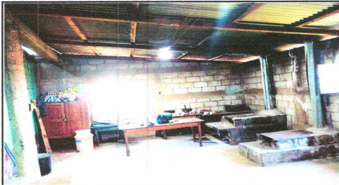
Foto1: Sustitución de lámina troquelada aluzin calibre 26.
