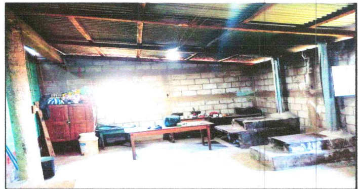
Foto 6: Reparación de repello y cernido de paredes.
