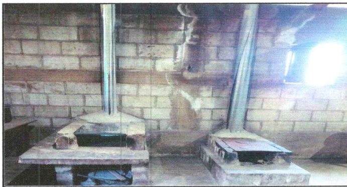
Foto 5: Sustitución de chimenea de metal.
