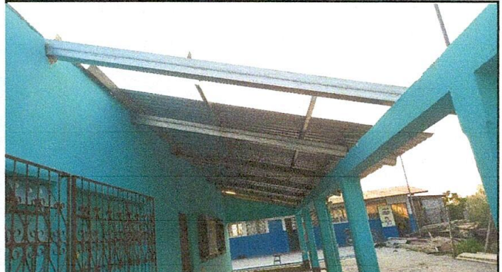
Foto No. 02. Proceso de mejoramiento del corredor del Centro Educativo, a través del cambio de láminas por Láminas Troqueladas Aluzinc Calibre 26.
