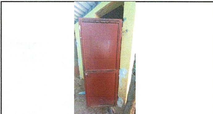
Foto No. 06, Sustitución de puertas de metal de baños para niñas.
