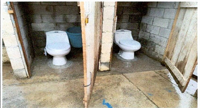
Foto 4: Se sustituyeron tres tazas para baños. Renglón de trabajo No. 10 SERVICIOS SANITARIOS Y SUS ACCESORIOS avalado por la asamblea de padres de familia, en conocimiento de acta de modificación No. 14-2024.
