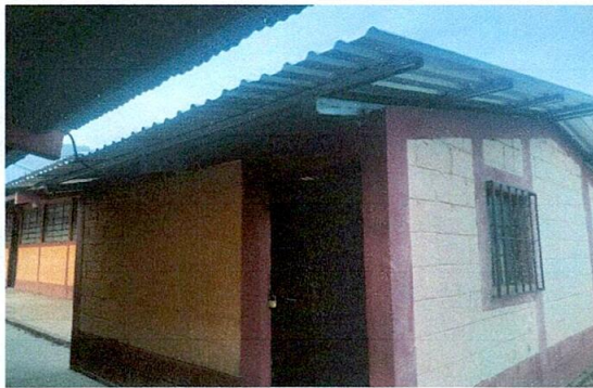
Foto 3: Se sustituyeron maderas por costaneras y el cambio de techo
