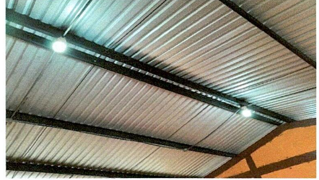
Foto 2: Cambio de techo e instalación del sistema eléctrico
