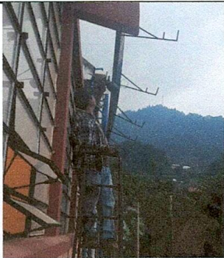
Foto 5: Pintada de costaneras de la escuela
