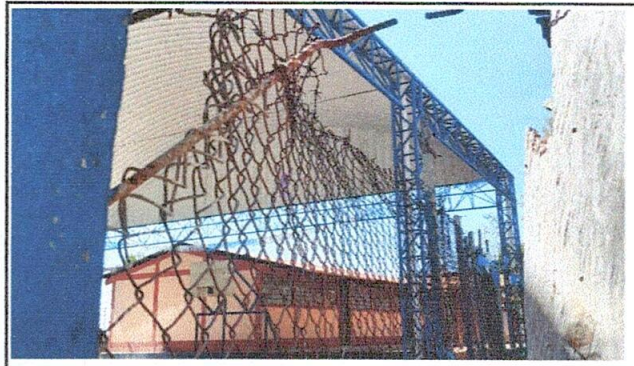
Foto 4: Sustitución de malla galvanizada.
