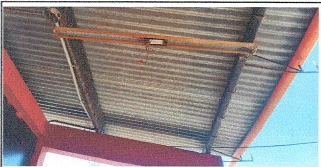
Foto 5: Sustitución de plafoneras.
