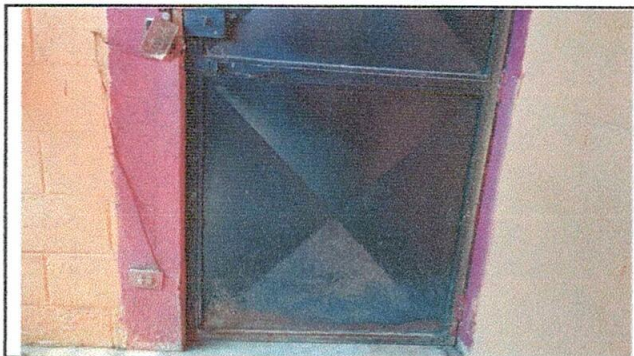
Foto 6: Mantenimiento de puerta de estructura de metal.
