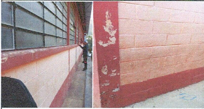
Foto 1: Vista detrás y de los lados de la escuela.
