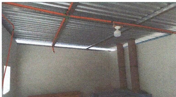
Foto 3: RENGLÓN No. 2. ESTRUCTURA DE TECHO, Sustitución de estructura de soporte de madera, por metal (Estructura de soporte del techo de la cocina)
