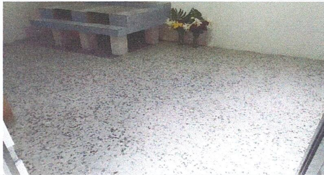
Foto 8: RENGLÓN No. 6. PISO, Sustitución de piso de granito (Piso de la cocina)
