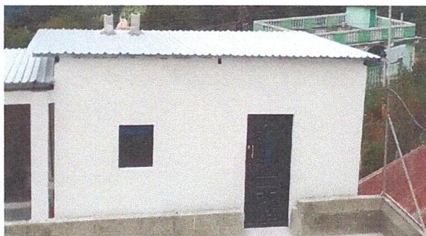
Foto 4: RENGLÓN No. 3. PUERTAS DE METAL, Sustitución de puerta (Puerta de la cocina)
