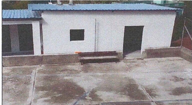
Foto1: RENGLÓN No. 1. CUBIERTA DE LÁMINA, Sustitución de lámina, por lámina troquelada aluzinc calibre 26. (Techo de la cocina)
