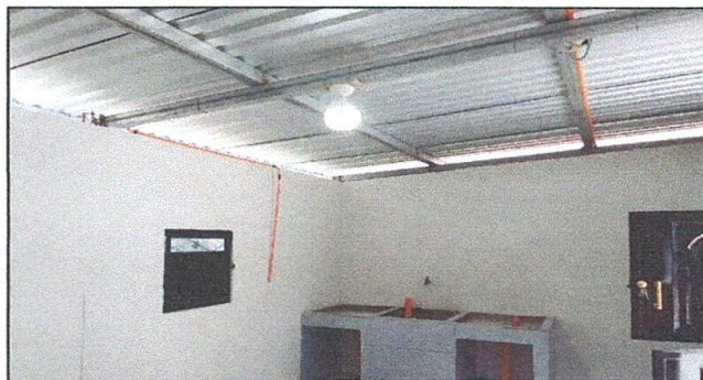
Foto 10: RENGLÓN No. 8. REPARACIÓN DE SISTEMA ELÉCTRICO, Sustitución de Focos ahorradores, plafoneras, interruptores y tomacorrientes (Sistema eléctrico de la cocina)
