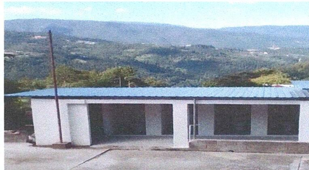
Foto 2: RENGLÓN No. 1. CUBIERTA DE LÁMINA, Sustitución de lámina, por lámina troquelada aluzinc calibre 26. (Techos de los baños)
