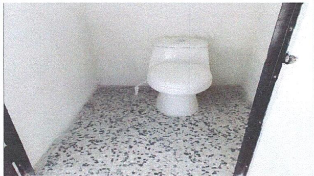
Foto 9: RENGLÓN No. 7. SERVICIO SANITARIO Y SUS ACCESORIOS, Sustitución inodoro (Inodoros de los baños)
