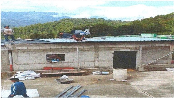
Foto1: RENGLÓN No. 1. CUBIERTA DE LÁMINA, Sustitución de lámina, por lámina troquelada aluzinc calibre 26. (Techo de la cocina)
