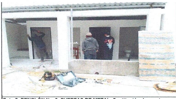
Foto 5: RENGLÓN No. 3. PUERTAS DE METAL, Sustitución de puerta en servicio sanitario (Puertas de los baños)
