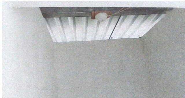
Foto 10: RENGLÓN No. 8. REPARACIÓN DE SISTEMA ELÉCTRICO, Sustitución de Focos ahorradores, plafoneras, interruptores y tomacorrientes (Sistema electrico de la cocina)
