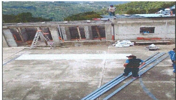
Foto 2: RENGLÓN No. 1. CUBIERTA DE LÁMINA, Sustitución de lámina, por lámina troquelada aluzinc calibre 26. (Techos de los baños)
