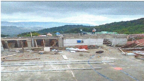
Foto 3: RENGLÓN No. 2. ESTRUCTURA DE TECHO, Sustitución de estructura de soporte de madera, por metal (Estructura de soporte del techo de la cocina)
