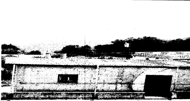
Foto 1: Techo de la cocina
