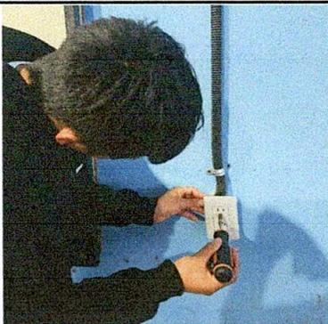
Foto 5: Instalación de tomacorriente doble en el módulo de aulas terminado.
