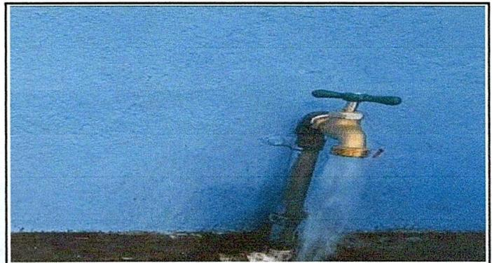
Foto 4: Instalación de chorros en el módulo de sanitario terminado.
