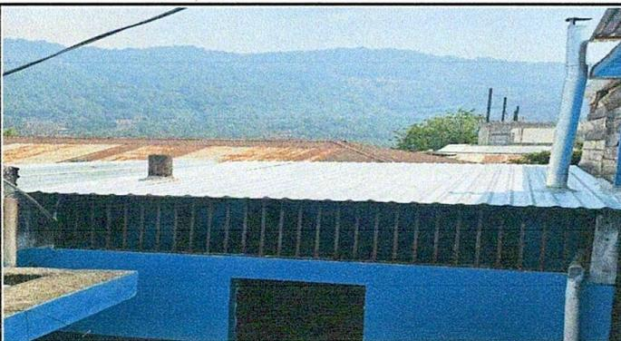
Foto 3: Instalación de lámina troquelada terminada.
