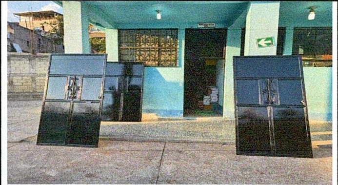
Foto 2: Pintado de puertas de aulas y sanitarios del establecimiento.
