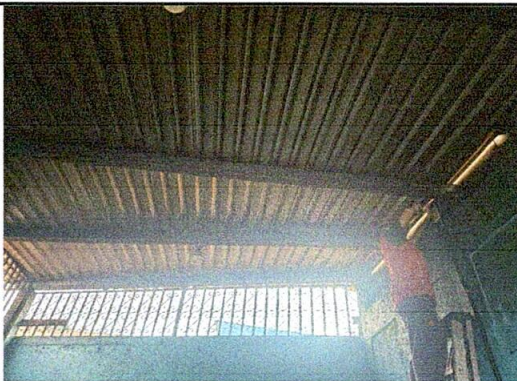
Foto 3: Instalación de lámina troquelada calibre 26 en el módulo de cocina.
