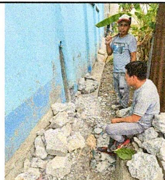
Foto 6: Proceso de reparación de muro de contención.
