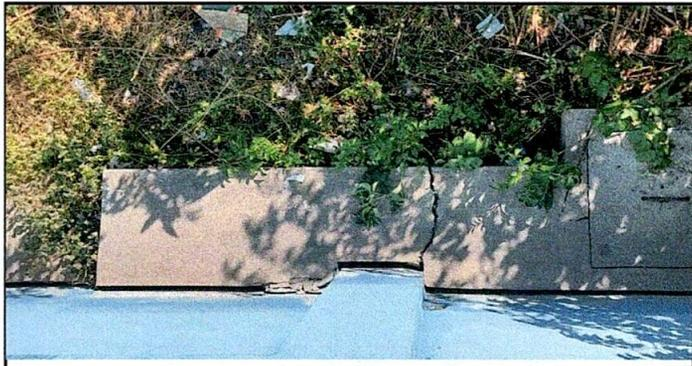
Foto 6: Reparación de muro de contención por agrietamiento causado por el desplazamiento, humedad, desgastes que se producen a lo largo del tiempo y diferentes fenómenos naturales.
