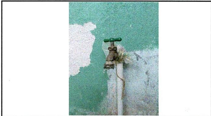
Foto 4: Sustitución de llaves de chorro por el mal estado en que se encuentran debido a su constante uso.
