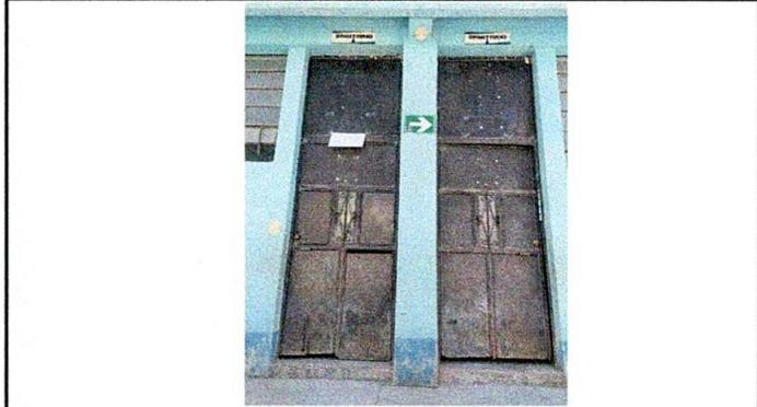
Foto 2: Sustitución de puertas de metal por la mala condición en que están debido a que regularmente se les cae agua, detergente, cloro, salpicadura por la lluvia y antigüedad.
