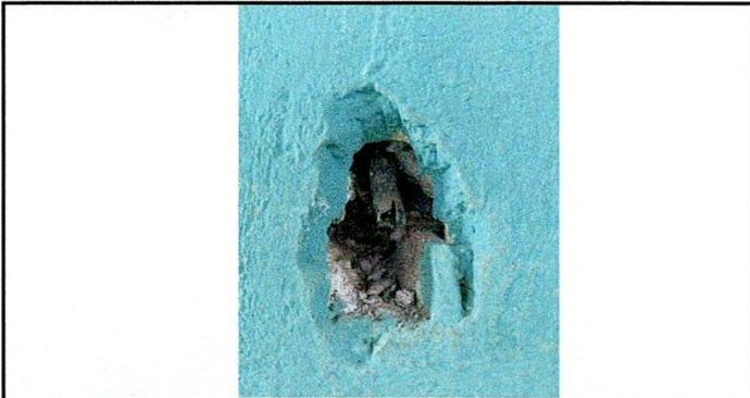
Foto 5: Sustitución de tomacorrientes dobles por deterioro total debido a la compatibilidad de aulas durante las jornadas de trabajo.
