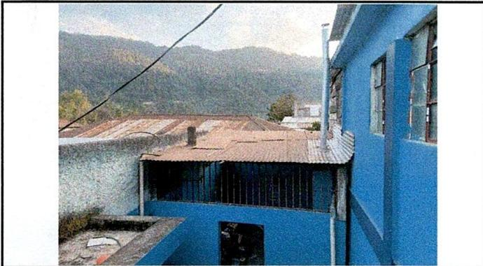
Foto 3: Sustitución de lámina de la cocina escolar debido al mal estado en que están y goteras que tienen.
