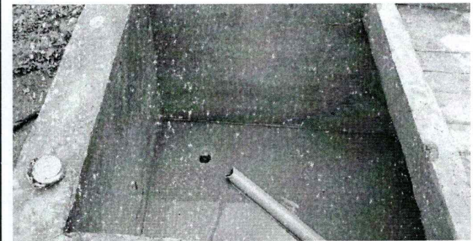
Foto 4: mantenimiento de una pila
