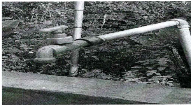
Foto1: sustitución de llave
