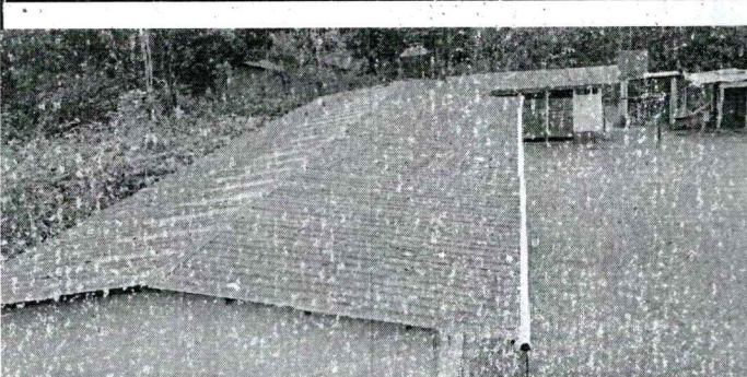
Foto 5: sustitucion de techo
