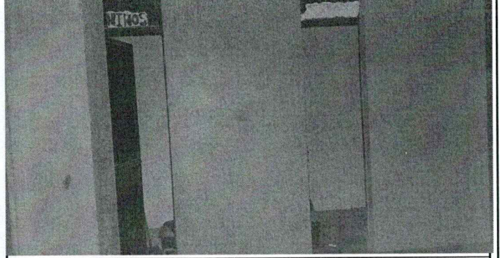
Foto 8: Mantenimiento a estructura, aplicación de pintura en puertas
