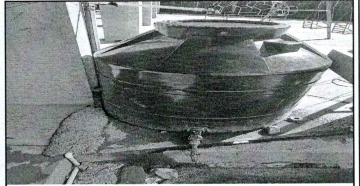
Foto 10: Sustitución de deposito de agua de 1100 lt
