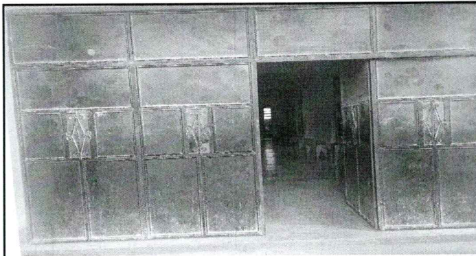
Foto 9: mantenimiento a porton de metal
