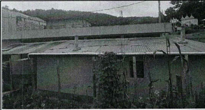
Foto1: Sustitución de lámina por lámina troquelada aluzinc
