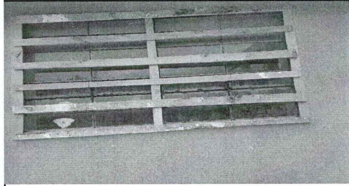
Foto 4: Sustitución de balcones de madera por metal
