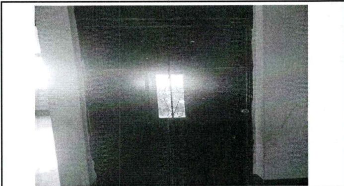
Foto 3: Mantenimiento a estructura, aplicación de pintura
