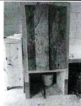
Foto 6: Sustitución de puertas en gabinetes de concreto
