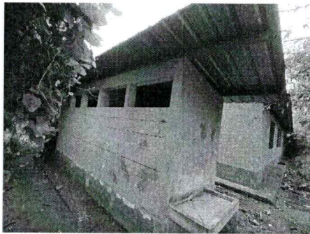
Foto 3: Mejoramiento de ventanas
