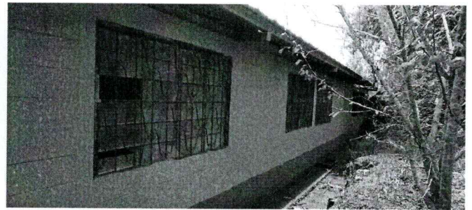
Foto 4: mantenimiento de balcones
