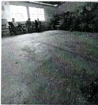
Foto 5: Mejoramiento de piso de granito en aulas, por presencia de grietas
