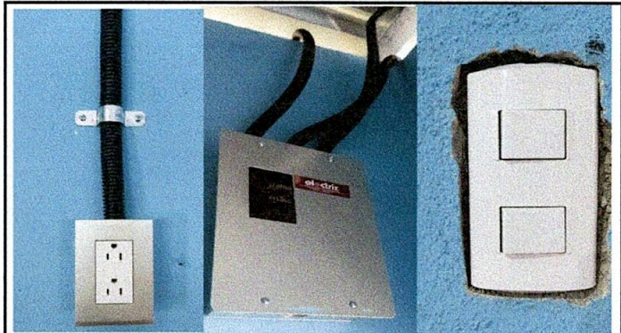
Foto 22: Evidencia fotográfica de la reparación y sustitución del ducto eléctrico + accesorios
