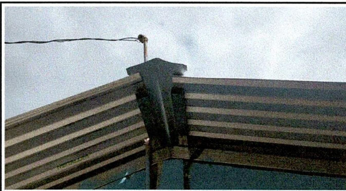
Foto 2: Evidencia Fotográfica de uso de capotes en el cambio de techo del centro educativo
