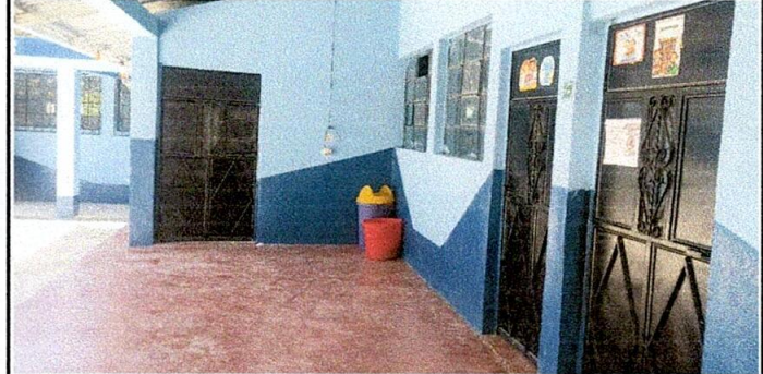
Foto 14: Evidencia fotográfica del mantenimiento de las puertas del centro educativo
