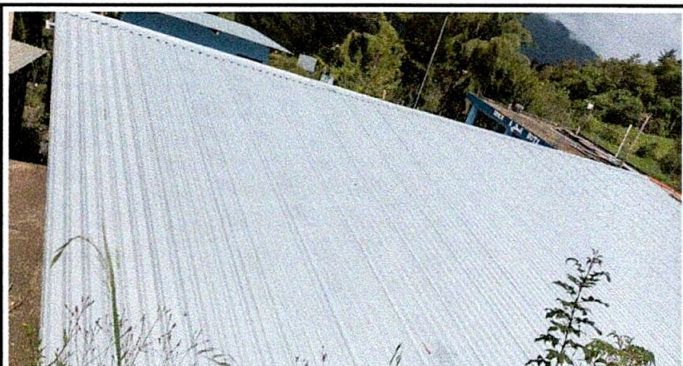
Foto3: Evidencia fotográfica del finalizado de cambio de techo del centro educativo
