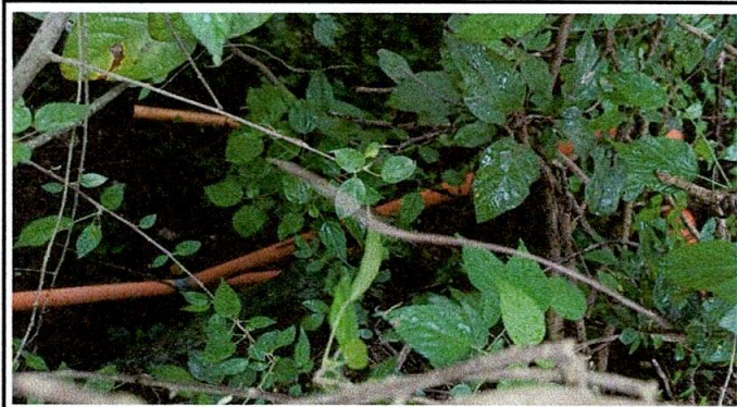
Foto 21: Evidencia Fotográfica de la red de drenaje remozado
